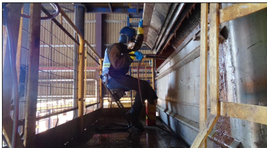
Figura 18 – Chapisco de rolo de moenda (rolo superior de entrada)
